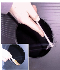
Očistite hrany a naneste mazací prostriedok.
