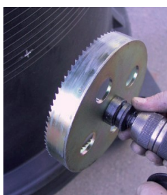
Vyvrátajte diery pre vstupné otvory.
